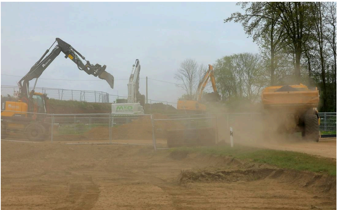
Am Montag sind die Bauarbeiten am Deich im großen Stil angelaufen.
